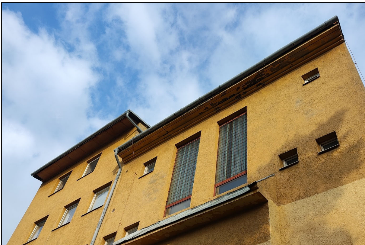
Pohled na JV stranu budovy, rorýs hnízdí v podhledech, 25. 4. 2024 (RK)
