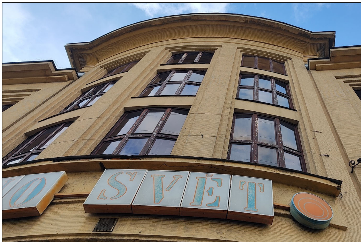
Čelní strana budovy (SZ), podobně JZ strana bez hnízdění, 25. 11. 2023 (RK)
